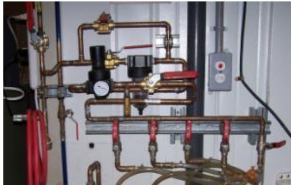
Figure 16 : Système d'air des gicleurs
