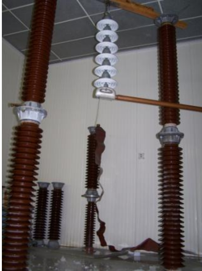
Figure 11 : Montage des isolateurs IEEE
